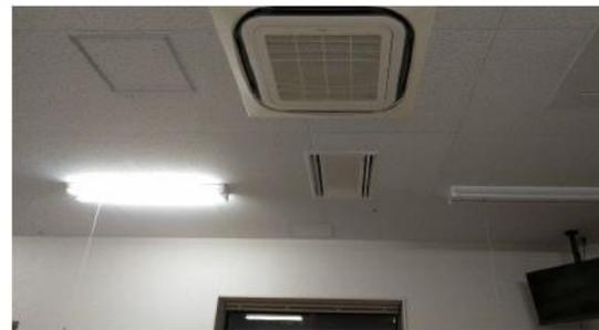
居室の換気量を確保する事に加え、後方から屋外への排気量も増加させます。
