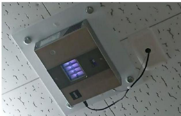
人体に悪影響のない紫外線を使用した、殺菌用光源「Care222」により狭い部屋での空気を清浄化します。222nm紫外線照射により、エアロゾル化した空気中のヒトコロナウイルスの99.9%以上が不活化されたことが報告されています。
